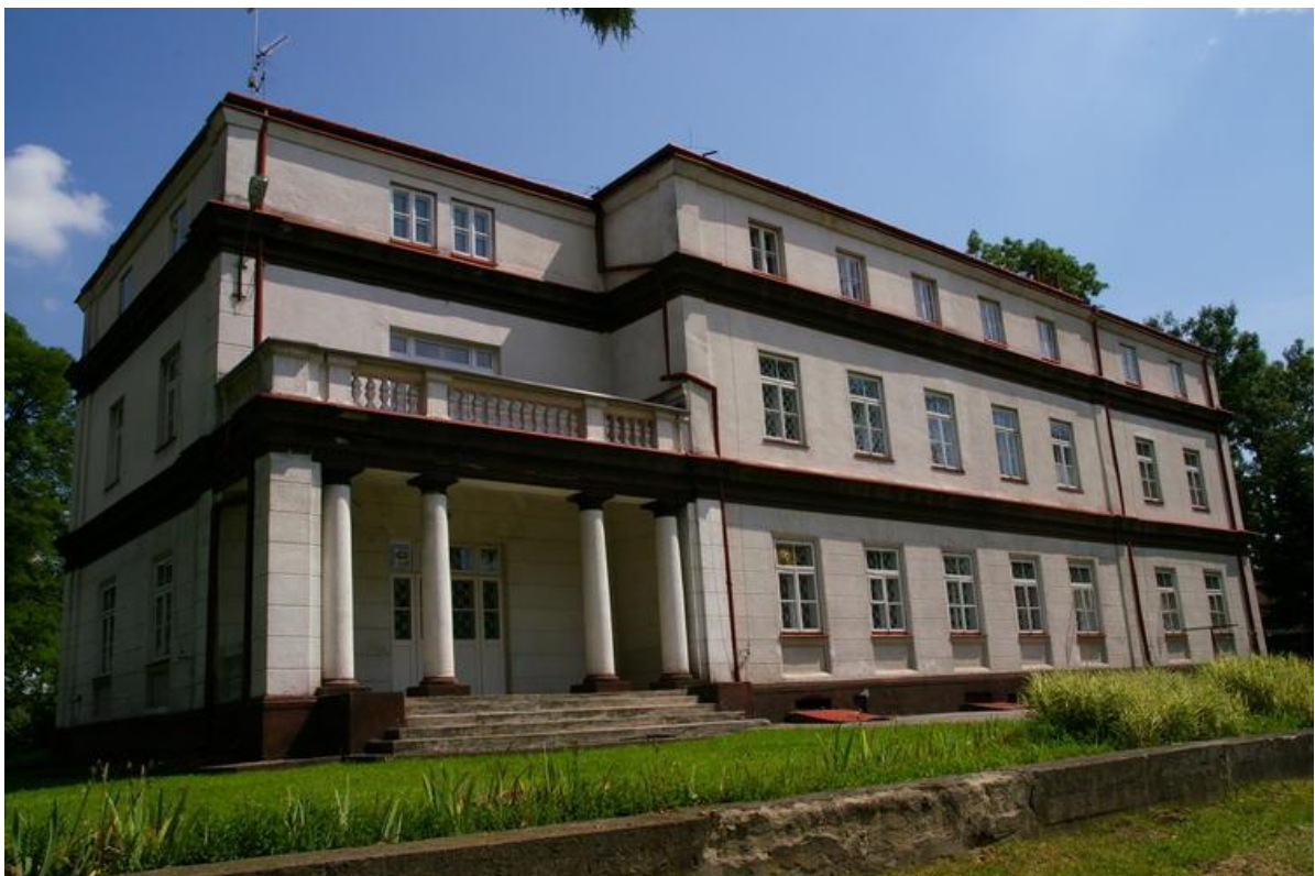
Stan obecny dworu po przebudowach
